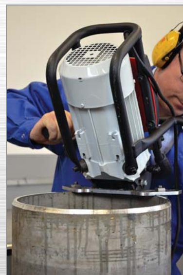
Снятие фаски на трубе
