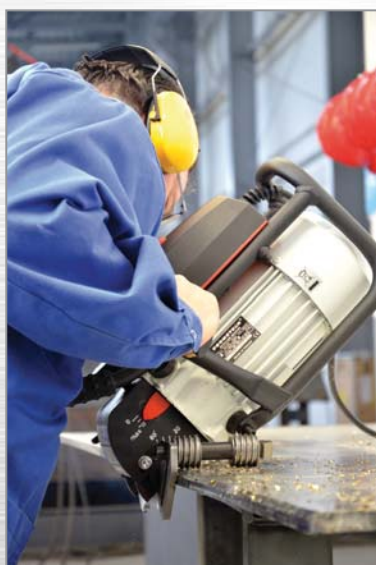
Снятие фаски на листе
