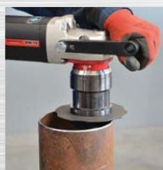
Снятие фаски с трубы
