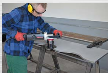
Снятие фаски на криволинейной кромке
